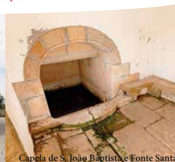
Capela de S. João Baptista e Fonte Santa
